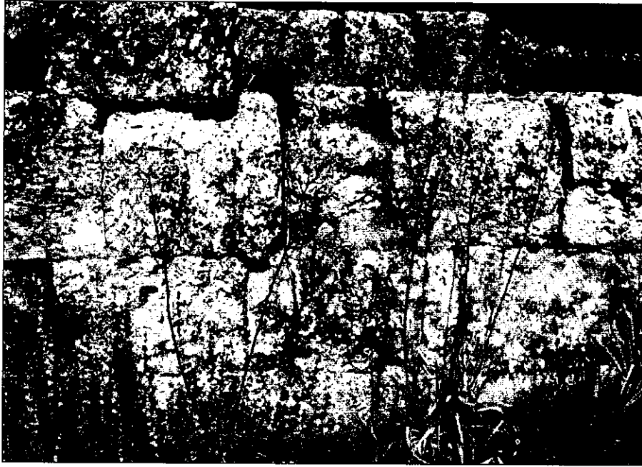
اللوحة رقم 7: المرسوم المستطيل ذي حجارة الربط و المعارضات و المرسوم المتراجع مبني بحجارة الفليس بمعبد التوأمين
